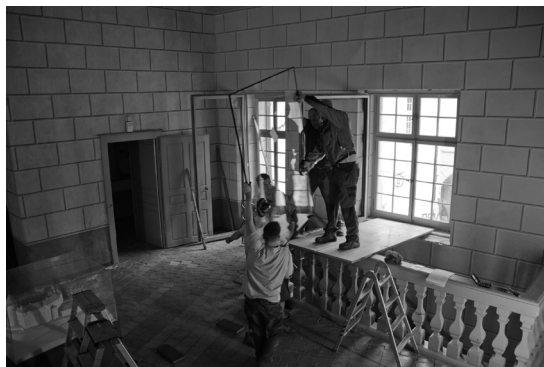
Pose des vitrages des fenêtres anti-feu dans le grand vestibule
