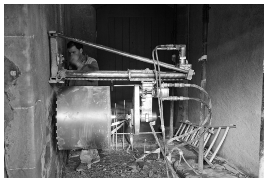
Percement du mur pour la ventilation de la chaufferie
