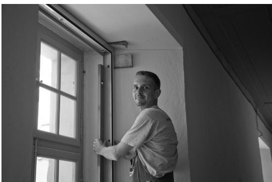
Pose des fenêtres anti-feu dans les corridors de l'appartement
