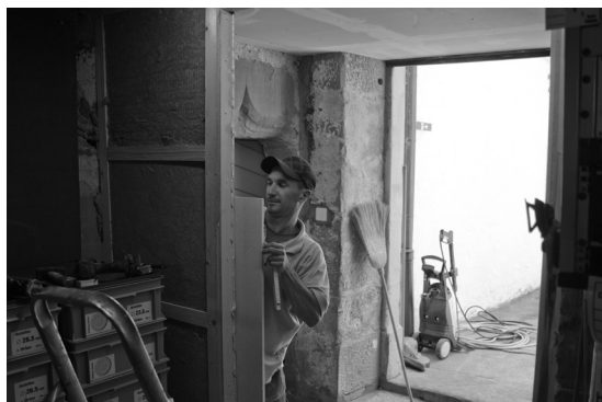
Nouvelle paroi anti-feu entre l'office et la Salle de Justice
