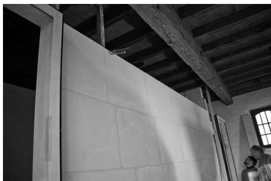
Nouvelle paroi de séparation au fond de la salle des Oron
