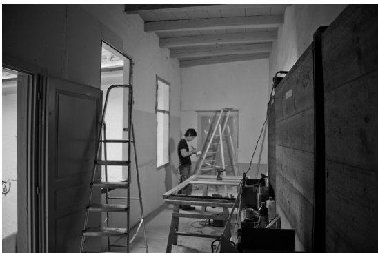
Corridor de la bibliothèque: doublage de la paroi à gauche
