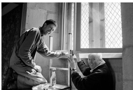
Pose des fenêtres anti-feu à la Salle des Gardes
