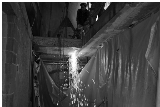
Perçage de la dalle dans la salle des Oron
