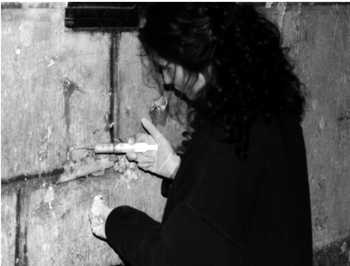
Les fissures et les lacunes sont comblées par un mortier à la chaux
