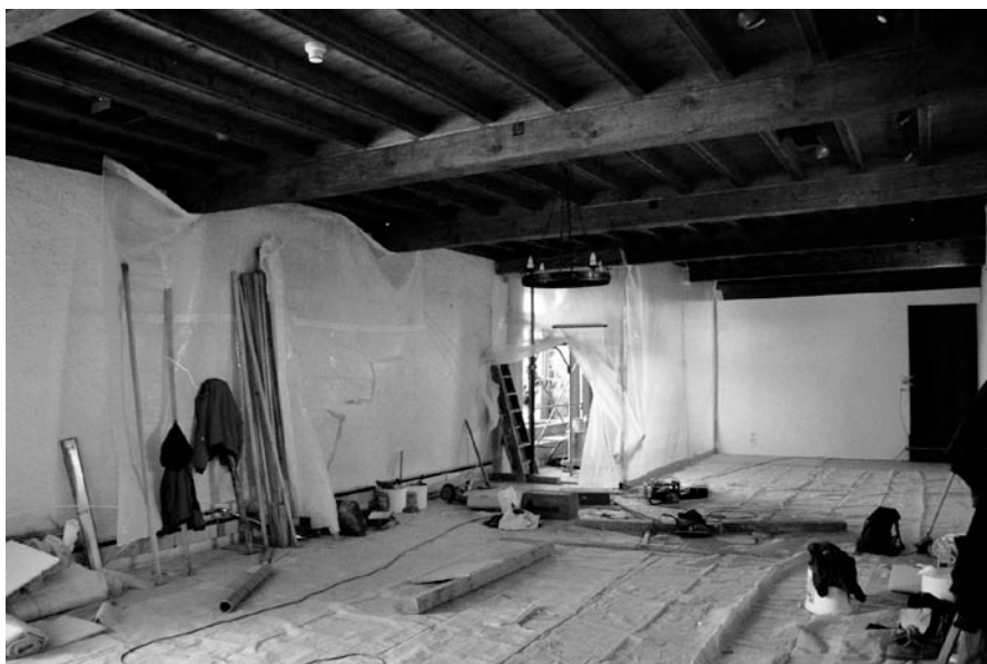
Salle des Oron pendant les travaux 2005
