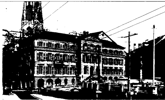
La maison d'Alt aujourd'hui avec son socle reconstruit en sous-cœuvre en 1905-1906 et en 1933
